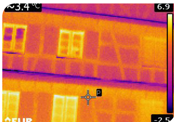
Une maison à l'épreuve de la caméra thermique.
