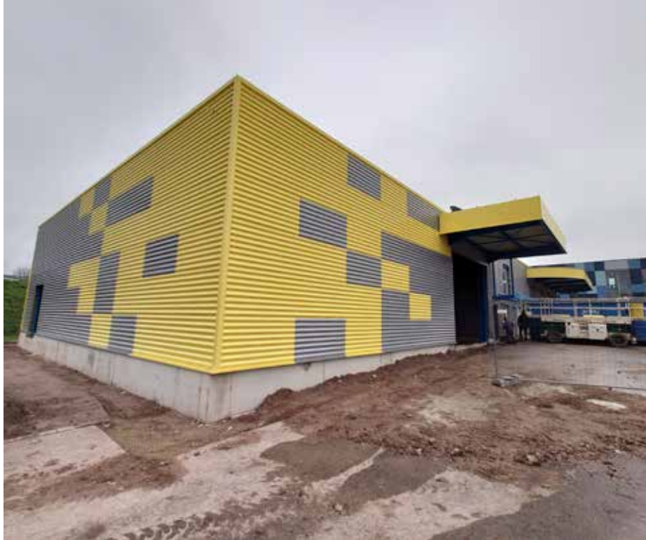
Nouveau hall de stockage - extension de l'atelier intercommunal
