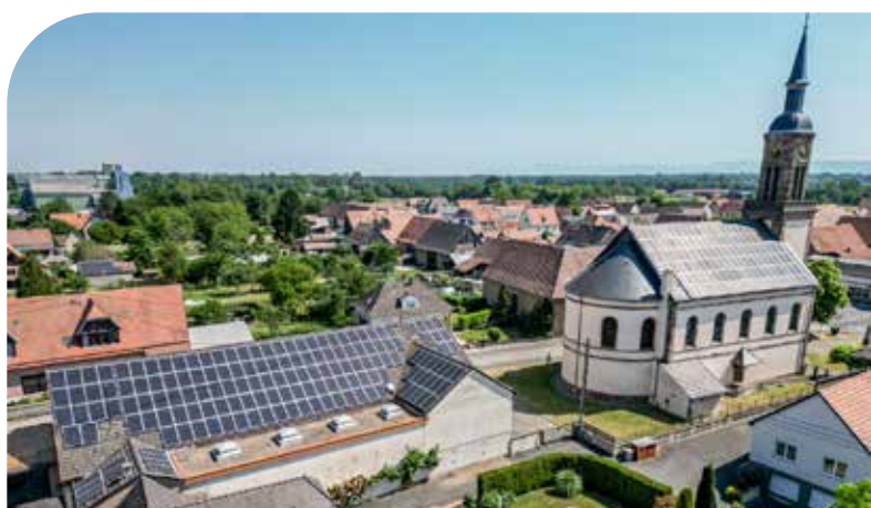
303 panneaux photovoltaïques installés sur les toitures de la salle des fêtes et du temple protestant
