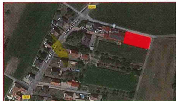
Google Maps 2022 – Entreprise Métallerie Bichel et parcelle 305 concernée par le projet de révision « allégée » n°1 (en rouge)
